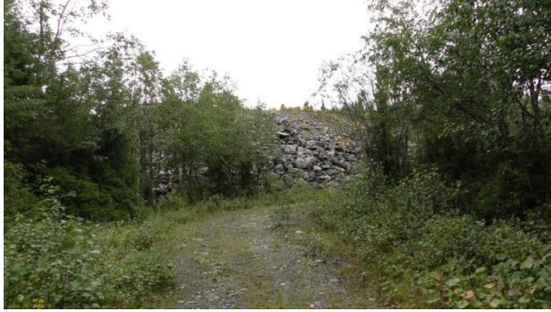
Steinfylling nedenfor bruddet.
