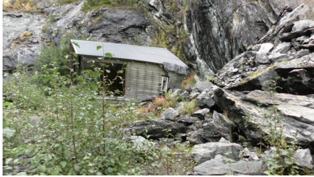
Scenebygget var sterkt skadet.
