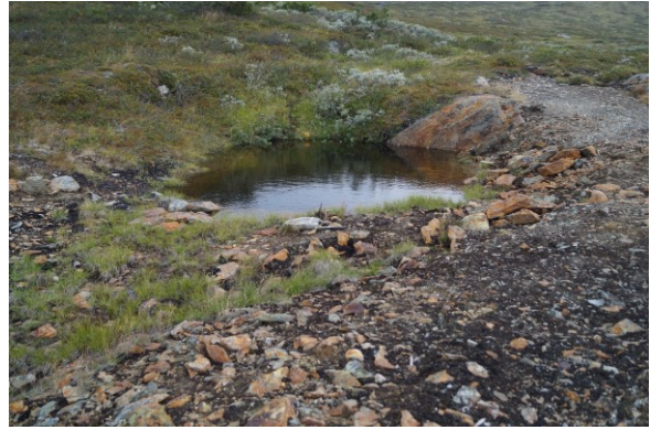
Sødalsgruva tv. og den vannfylte skråsynken til høyre. NGU har anslått at det er ca. 15 000 m 3 masse i bergtippen.
